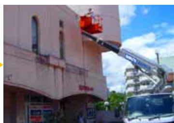
高所作業車を使用して高いところもしっかり施工！
