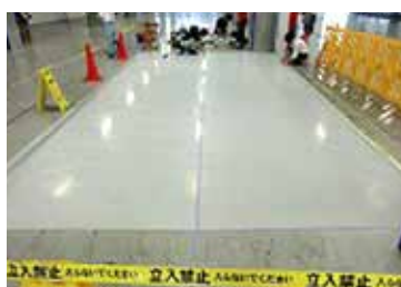
コーティングのための養生をします
