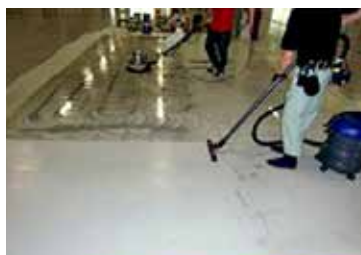
洗浄した汚水をバキュームします
