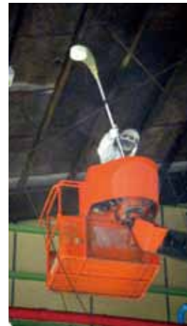
2 高圧洗浄機でコンクリートに付着した汚れを取り除きます。
