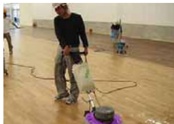
下地処理 硬いバットで床材の表面をしっかりと洗います。
