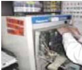
消防設備改修工事
