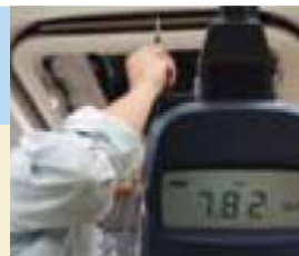
空調 エアコン風量測定
