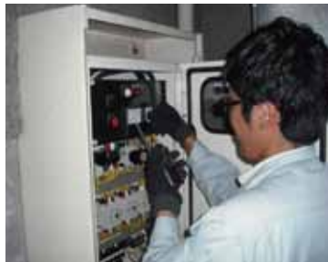
自動火災報知設備 受信機操作確認
